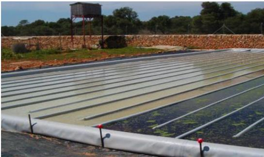
Figura 5.- En las lagunas de alta velocidad, las variables controlables son la profundidad de la laguna, el mezclado, carga hidráulica y orgánica, exceso de sólidos sedimentables, ajuste del pH y del dióxido de carbono o el suplemento de nutrientes. (Foto tomada de Internet).
