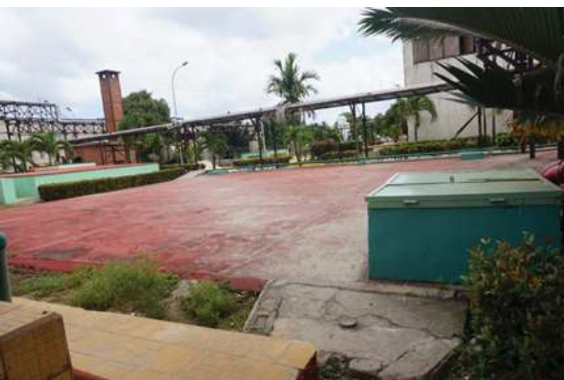
Figura 1.- Cisterna que recepciona el agua en el CIM, (Foto de la autora).
