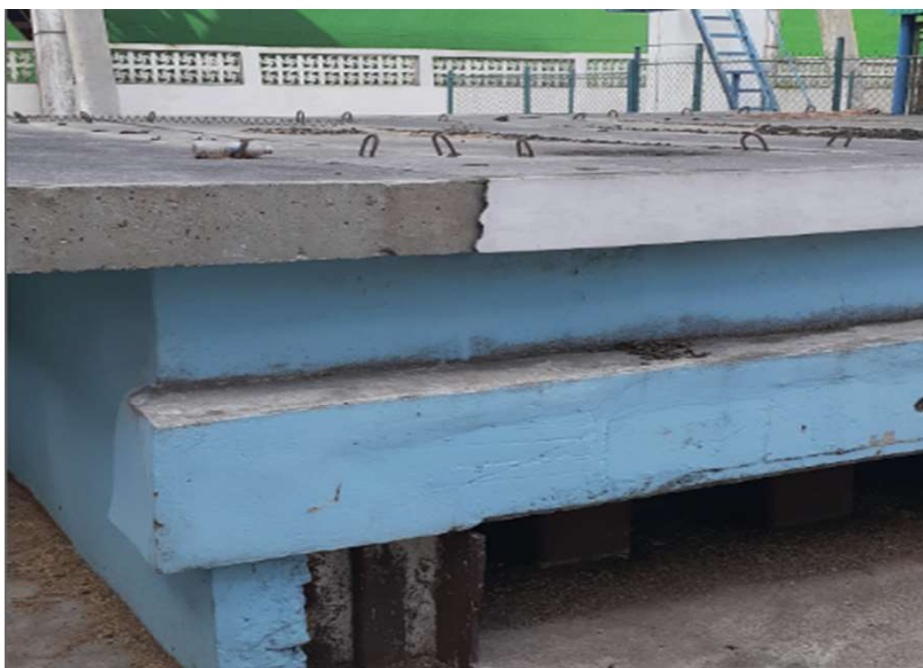
Figura 4.-Tanque séptico que se encuentra en la UEB Turcios Lima (Tomado de González, 2022).
